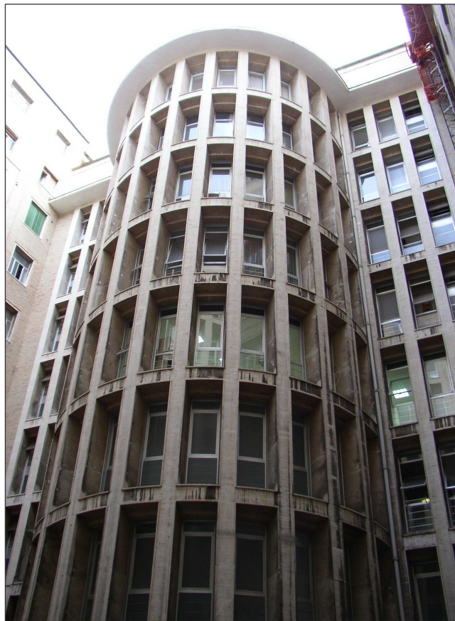
Napoli - Direzione Regionale della Campania - "Torre della formazione"
